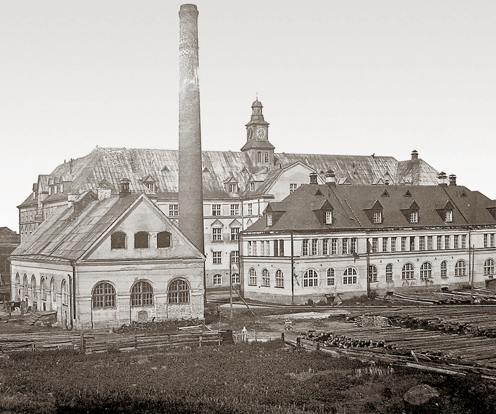
Комплекс зданий Ночлежного дома им. Е. И. Мешковой, начало XX века
