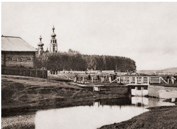
Мост через р. Ершовку
