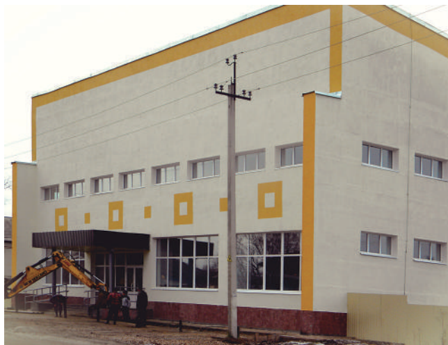
Завершение строительства торгового центра Юсьвинского райпотребсоюза
