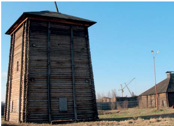
Усть-Боровской солеваренный завод, рассолоподъемная башня
