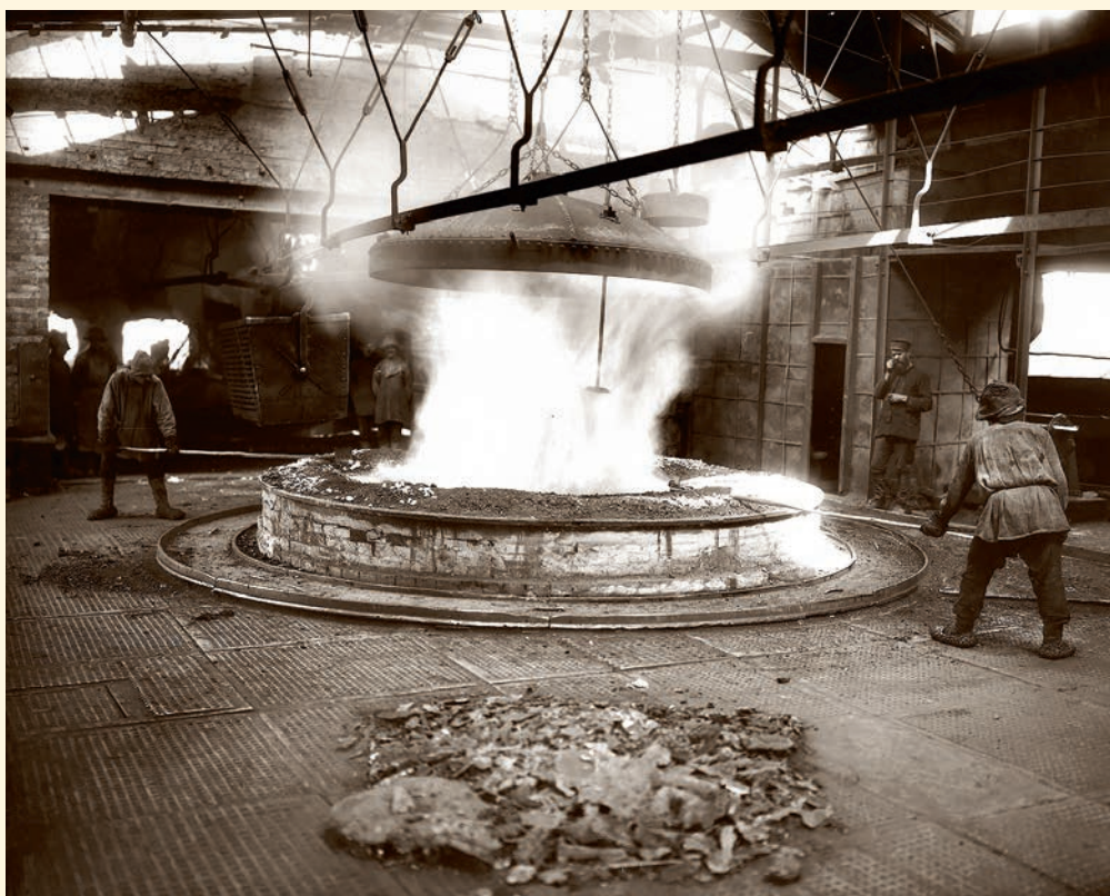
Кизеловский завод. Засыпка шихты в доменную печь. Начало XX в. Из фондов Пермского краеведческого музея
