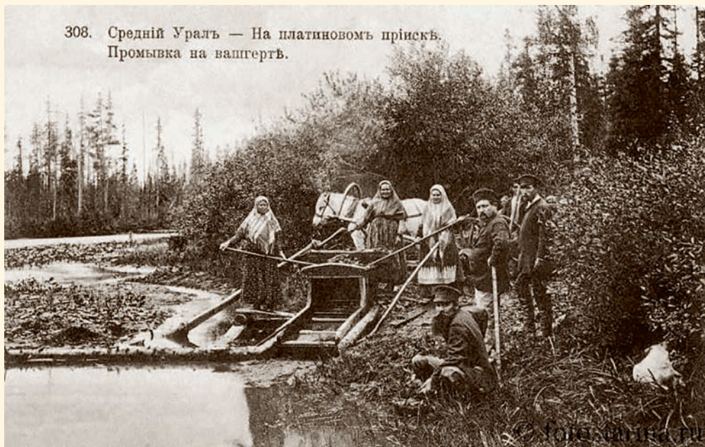
Средний Урал. На платиновом прииске. Промывка на вашгерте. Почтовая открытка начала XX в. fotostarina.ru
