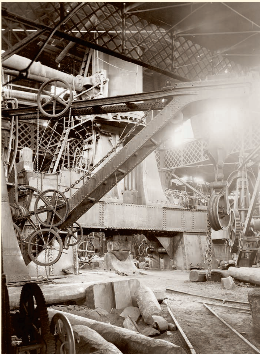
Паровой 50-тонный молот. Пермские пушечные заводы. Мотовилиха. Конец XIX в. Из фондов Пермского краеведческого музея
