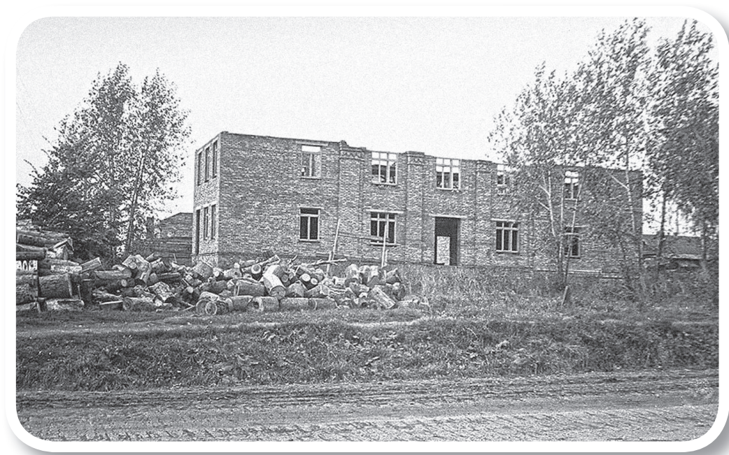
Строительство Дома культуры. Сентябрь 1969 г.
