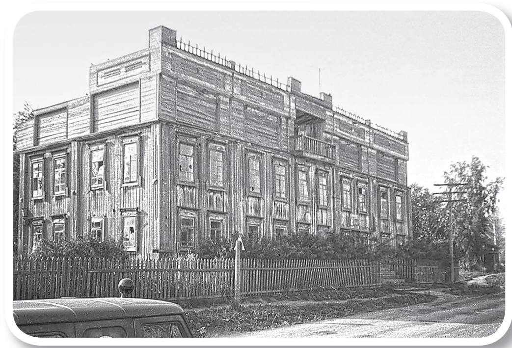
Старое здание школы. 1969 г.
