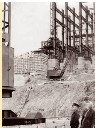
Горно-обогатительный комбинат строится
