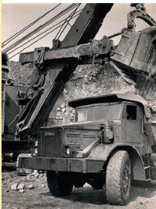
Вскрышные работы. Вывоз грунта
