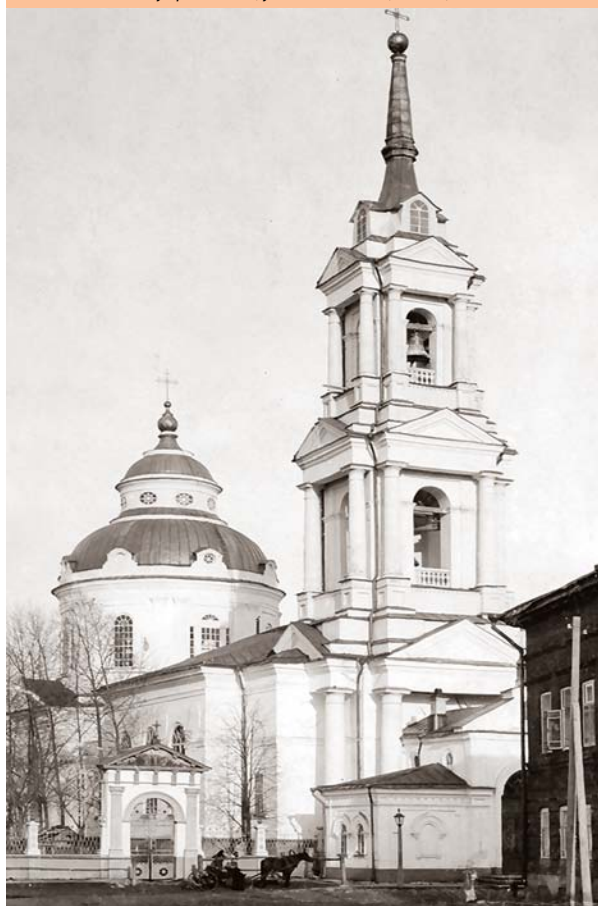
Покровская церковь, ул. Б. Покровская, 42, 1808-1815 гг.
