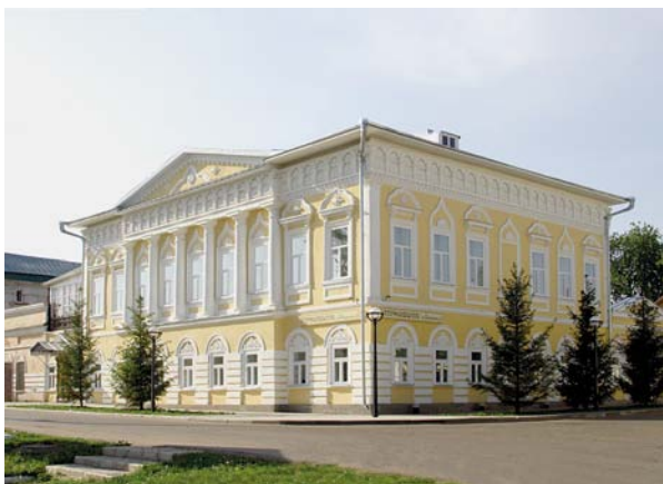
Комплекс городского банка Стахеевых, ул. Спасская, 1, 1835 г.
