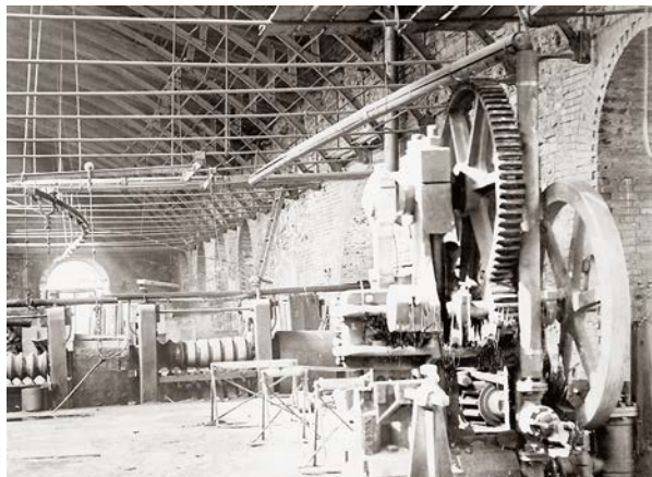
Прокатный цех Добрянского завода, фото нач. XX века
